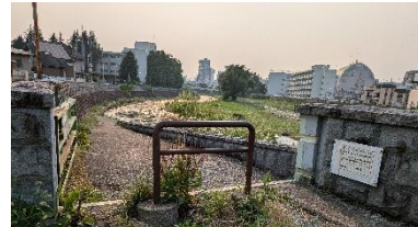
写真3 看板を設置した 下の橋周辺の様子
